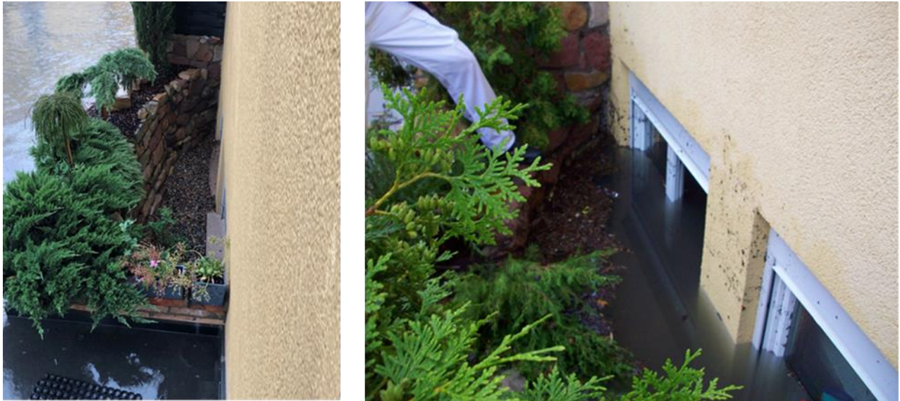
Abb. 70: Erfolgreicher Objektschutz 2021 (links), Überflutung 2009 (rechts), Fotos: Becker
