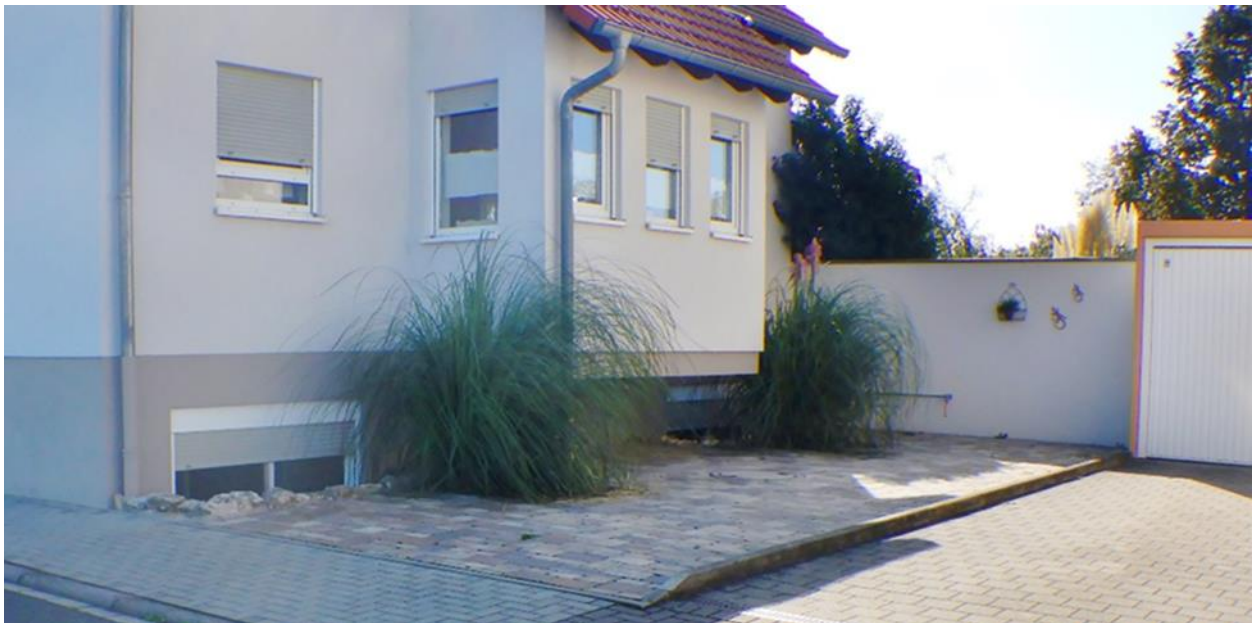
Abb. 63: Überflutungsgefährdetes Untergeschoss und überflutungsgefährdete Garage
