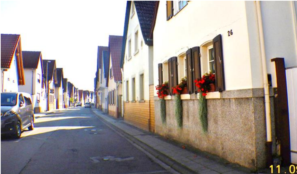
Abb. 66: Altbebauung ohne überflutungsgefährdete, tiefliegende Gebäudeöffnungen
