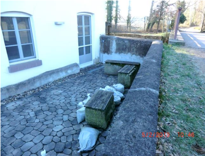
Abb. 17: Überflutungsgefährdete Obermühle mit bereitliegenden Sandsäcken
