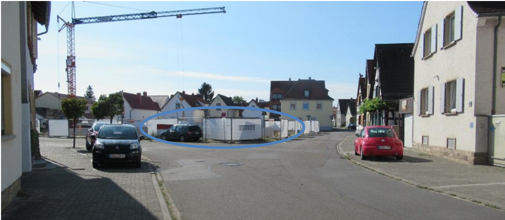
Abb. 29: Ehemals geeigneter Standort für Retentionsmaßnahme, zwischenzeitlich auch mit überflutungsgefährdeter Tiefgarage überbaut
