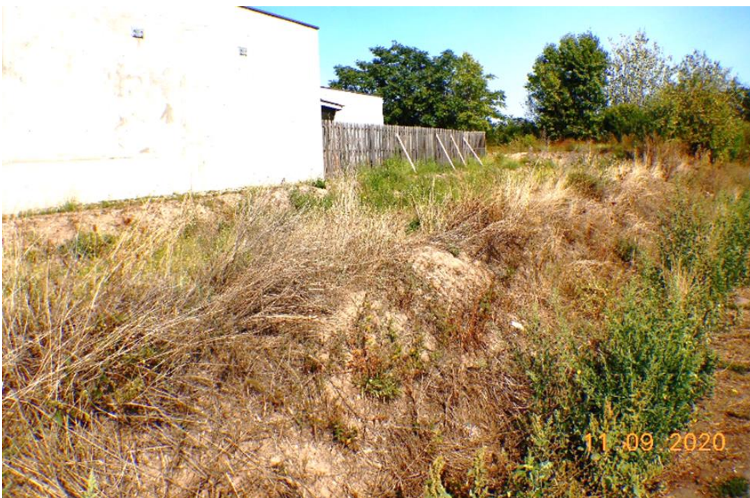
Abb. 34: Beispiel für eine unterhaltungsbedürftige Sickermulde
