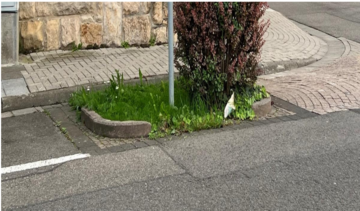
Abb. 24: Baumstandort in Haßloch, dem zufällig Oberflächenwasser der Straße zufließen kann
