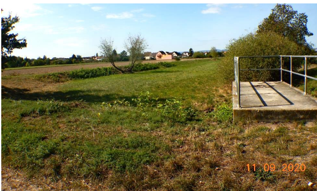
Abb. 48: RÜB 2 und Polder „Langer Graben“
