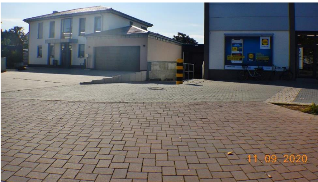
Abb. 30: Beispiel für extreme Flächenversiegelung im Ortskern (Mischwasserkanal)
