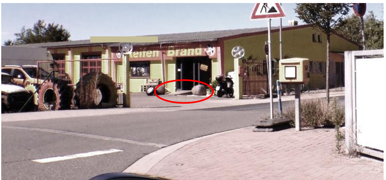
Abb. 52: Beispiele für überflutungsgefährdete Betriebe im Gewerbegebiet Süd
