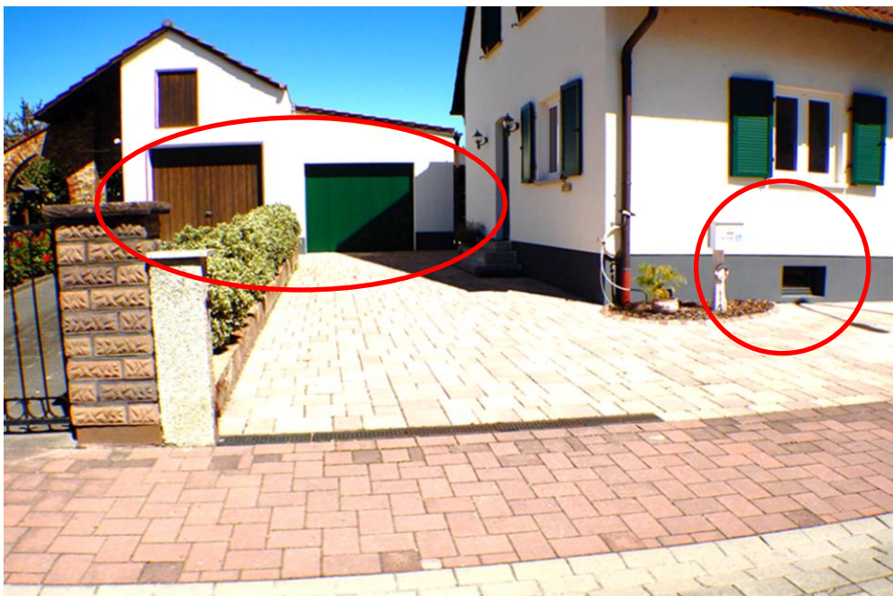
Abb. 50: Potenziell überflutungsgefährdete Wohnhäuser
