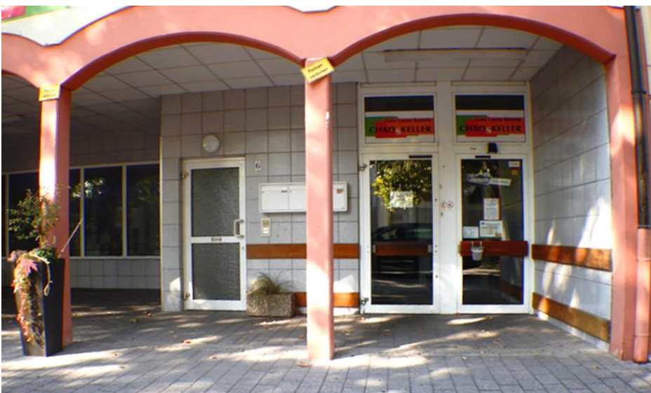
Abb. 64: Beispiele für überflutungsgefährdete tiefliegende Gebäudeteile
