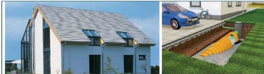
*Klimaangepasstes Bauen am Beispiel einer hellen Dacheindeckung zur Hitzevorsorge (links) und eines dezentralen Regenwasserrückhalts zur Starkregenvorsorge (rechts)*
