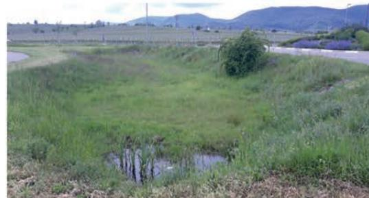
Abb. 3: Exemplarische Versickerungsmulden zur gezielten Ableitung von Oberflächenwasser
