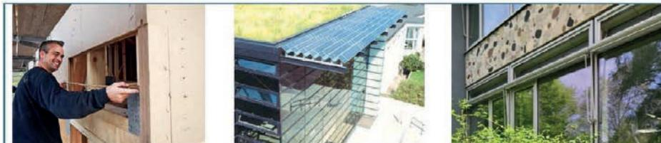
Links: Dämmung mit nachwachsenden Dämmstoffen (hier: Holzfaserplatten – beugt Hitzestau vor, ist nachhaltig und sorgt für ein behagliches Raumklima); mittig: Sonnenschutzsystem mit integrierter Photovoltaik neben extensiver Dachbegrünung & rechts: 3-fache Wärmeschutzverglasung und mechanische (Nacht-) Lüftungskappen als Oberlichter - kontrollierte natürliche Be- und Entlüftung möglich
