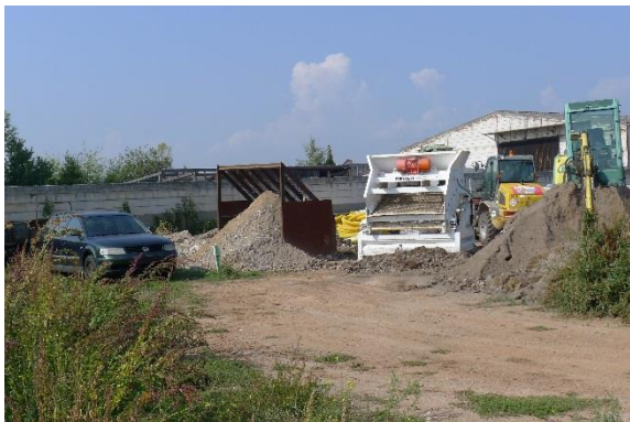
Lager und Aufbereitung Tiefbau alle Aufnahmen Büro Ehrenberg 2017
