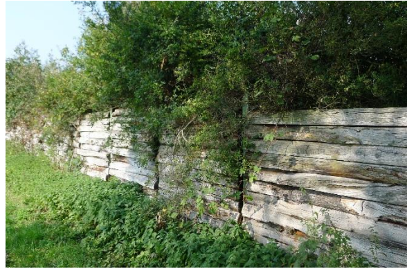
Südgrenze ehem. Gartenanlage
