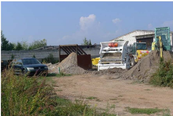
Abbildung 20: Lager und Aufbereitung Tiefbau Quelle: Büro Ehrenberg 2017
