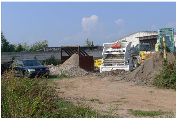
Lager und Aufbereitung Tiefbau
