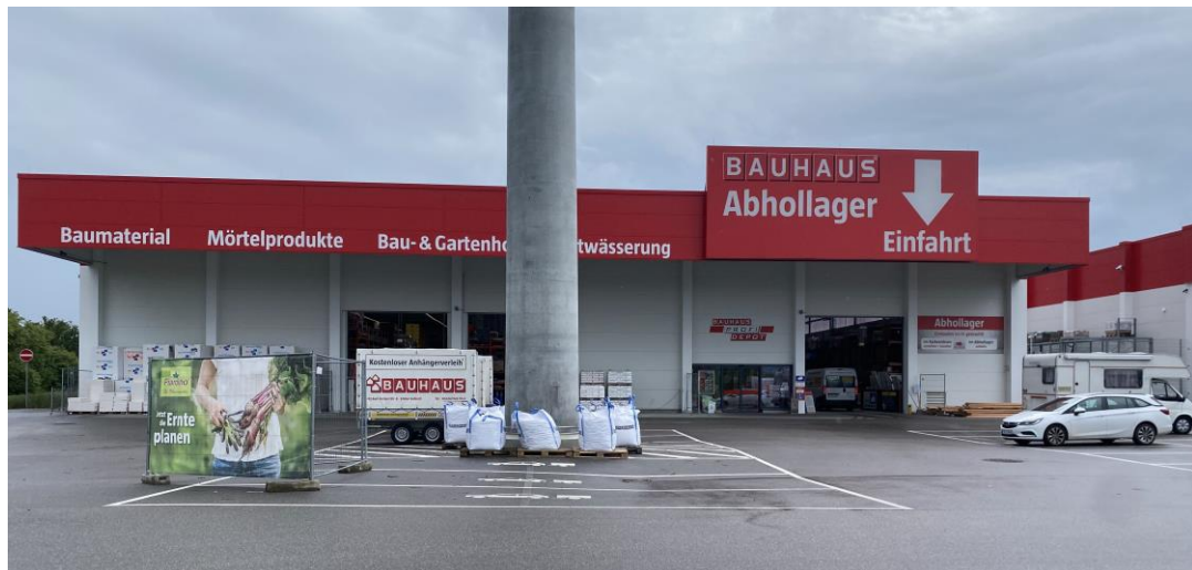
Abbildung 2: Blick auf den Vorhabenstandort (derzeitige Nutzung als BAUHAUS-Abhollager)
