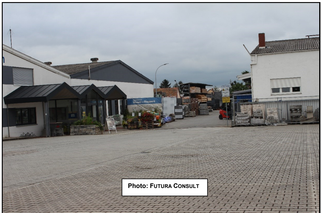
Photo: I&M Bauzentrum Mayer + Ruppert in Hochdorf-Assenheim
