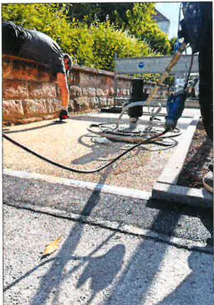
Eine PU-Asphalt-Mischung wird auf den Bürgersteig in der Löwenbrunnenstraße in Pirmasens aufgetragen.
