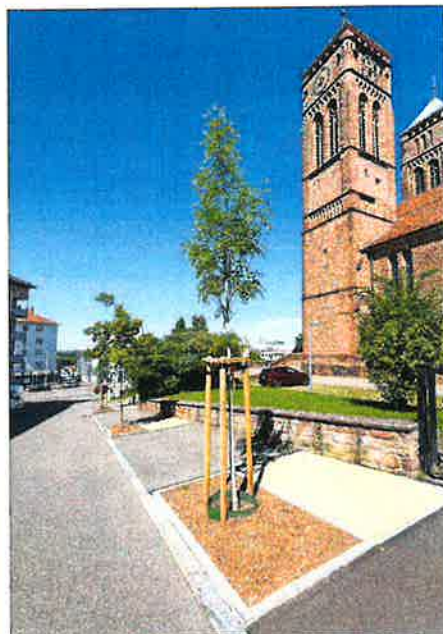
Der hellbeige Gehwegbelag ist wasser- und luftdurchlässig, was der Bewässerung der Baumwurzeln zugutekommt.
