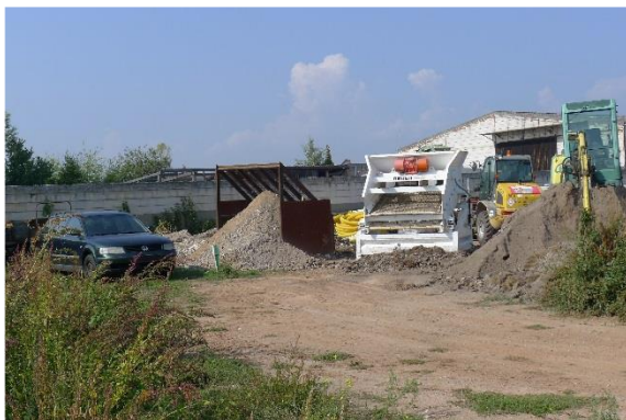
Abbildung 21: Lager und Aufbereitung Tiefbau Quelle: Büro Ehrenberg 2017
