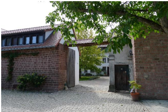
Hoftor und Zufahrt Obermühle
