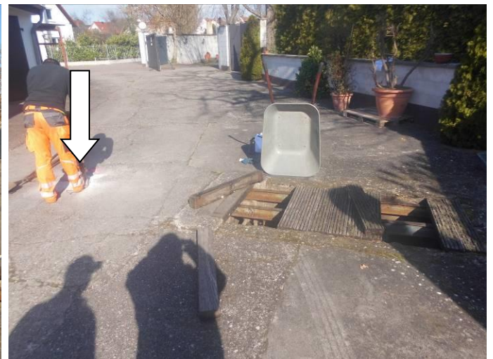
Bild 5: Bohransatzpunkt RKS 2 (Pfeil) und Domschacht mit Abdeckung
