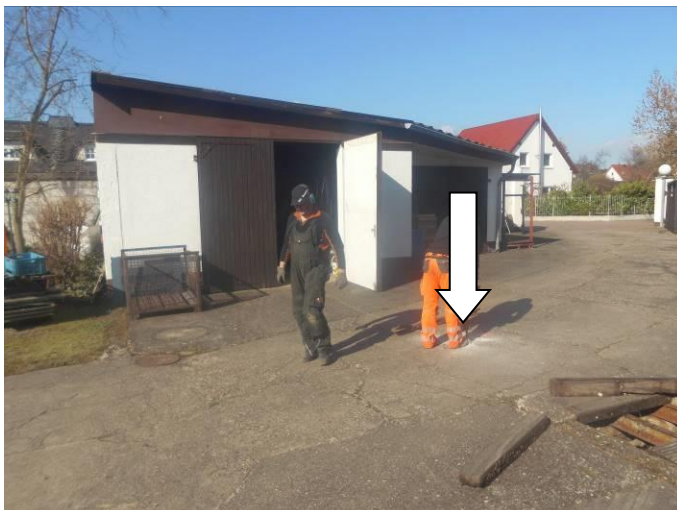
Bild 4: Bohransatzpunkt RKS 2 (Pfeil)
