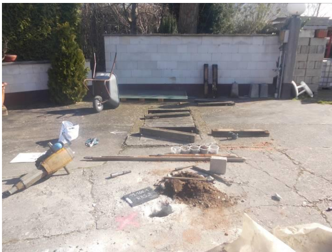
Bild 8: Bohrung RKS 2 auf Höhe des Erdtanks
