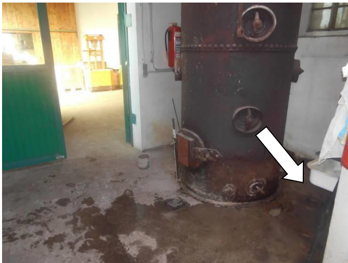
Bild 19: Lage der Bohrung RKS 5a im Kesselraum
