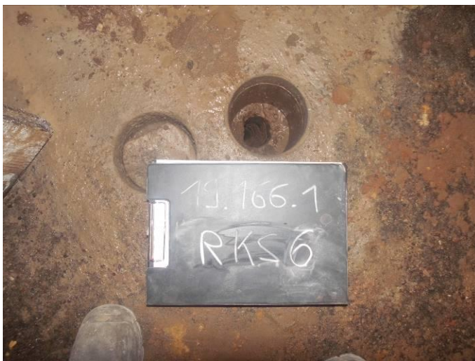
Bild 25: Kernbohrung der RKS 6
