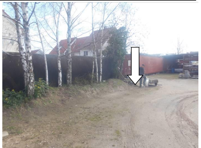
Bild 13: Hofbereich und Blick auf RKS 3 und Tank
