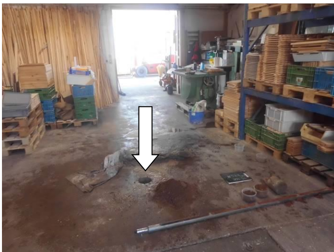
Bild 16: Lage Bohrung RKS 4 (Pfeil) in Schreinerei
