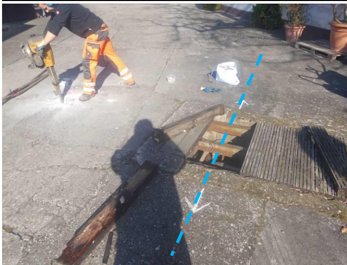
Bild 6: Orientierung/Längserstreckung des Erdtanks
