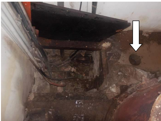
Bild 21: Lage der abgebrochenen Bohrung RKS 5 neben Leitungsschacht im Kesselraum
