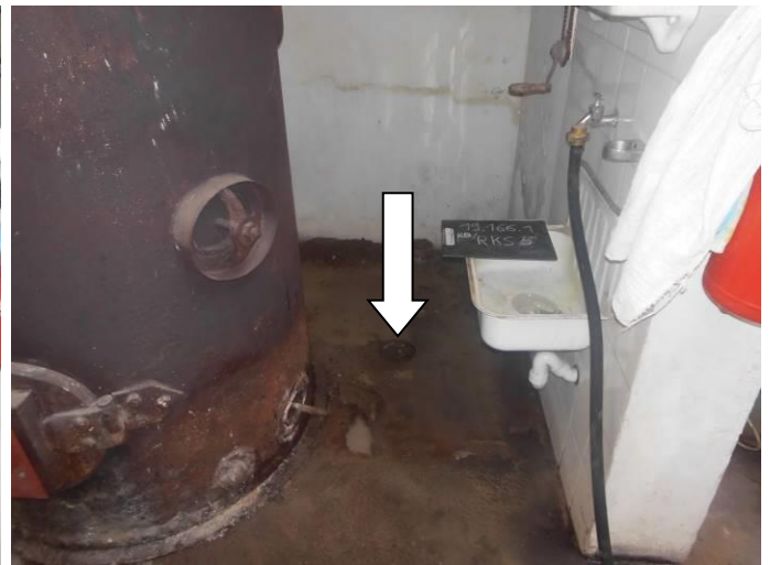
Bild 20: Lage der Bohrung RKS 5a (Pfeil) neben Kessel
