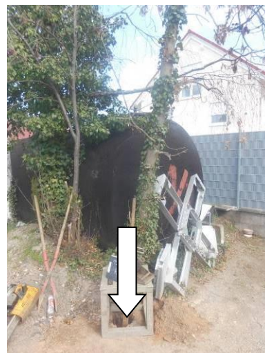
Bild 11: Bohrung RKS 3 (Pfeil) beim oberirdischen Tank in Nähe der Befüllung
