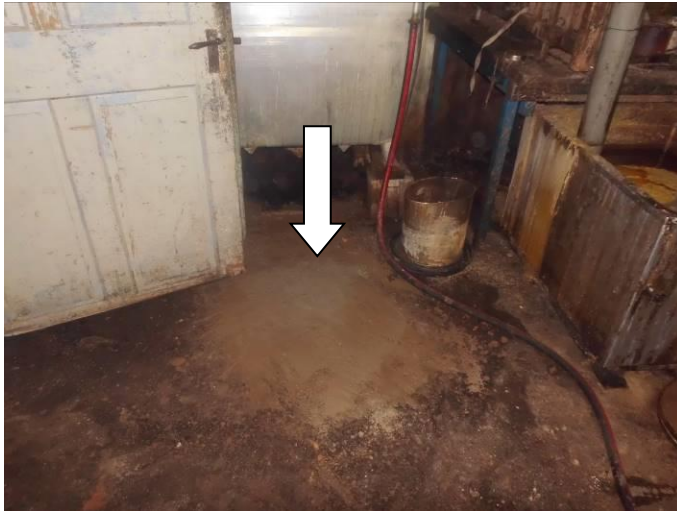
Bild 23: Lage der Bohrung RKS 6 im Tensidraum
