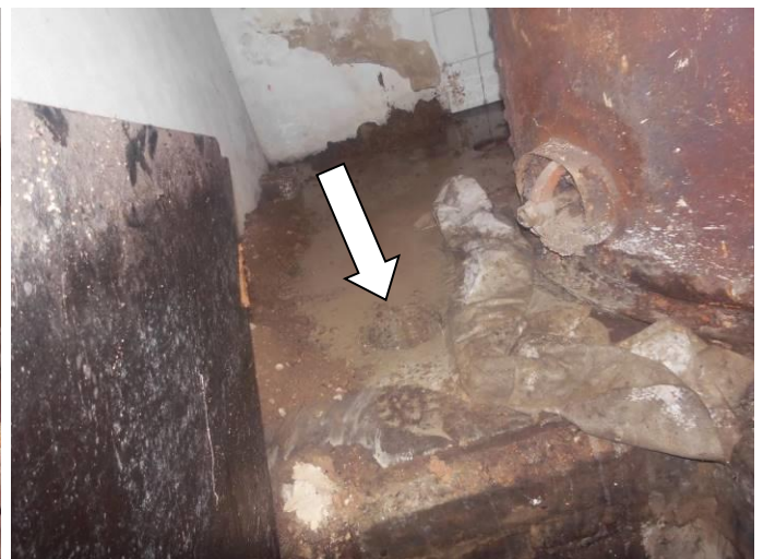
Bild 22: Lage der abgebrochenen Bohrung RKS 5 neben Leitungsschacht im Kesselraum
