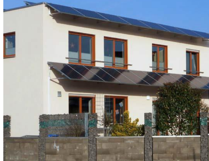
Photovoltaik als Hitze- und Sonnenschutz
